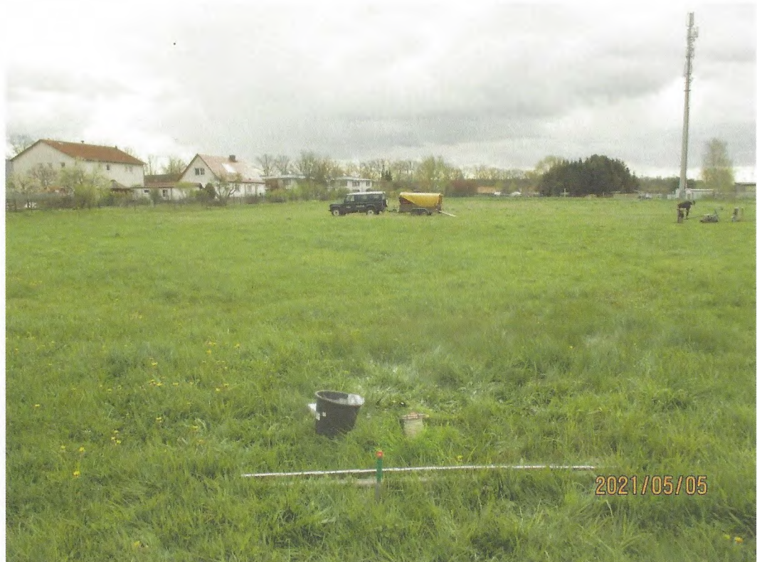
Blick über das Baufeld in östliche Richtung
